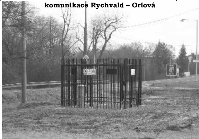
Oplocené ústí odvodňovací šachtice (Rychvald)
